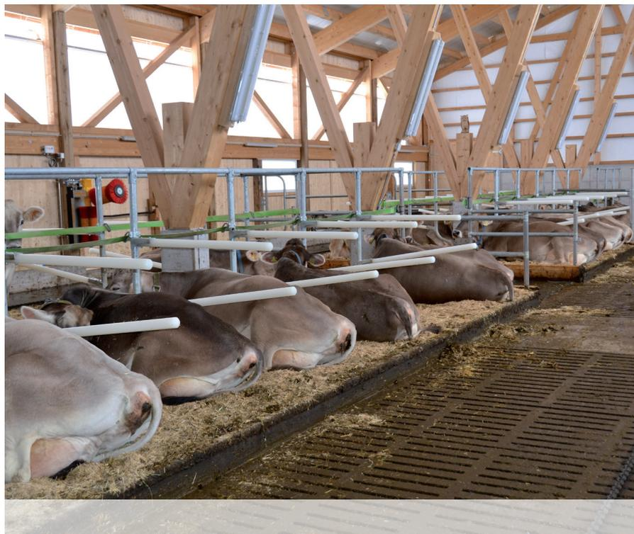
Die flexiblen Kunststoffprofile leiten die Kuh beim Betreten und Hinlegen in die Liegeboxe. Die frontseitige Begrenzung erfolgt mit einem 75 mm Nackengurt. Der Comfortbügel bietet der Kuh ungehindertes Abliegen und Aufstehen. Befestigung vom Bügel erfolgt mit vier CNS-Bolzenanker-Schrauben auf den Betonboden.
