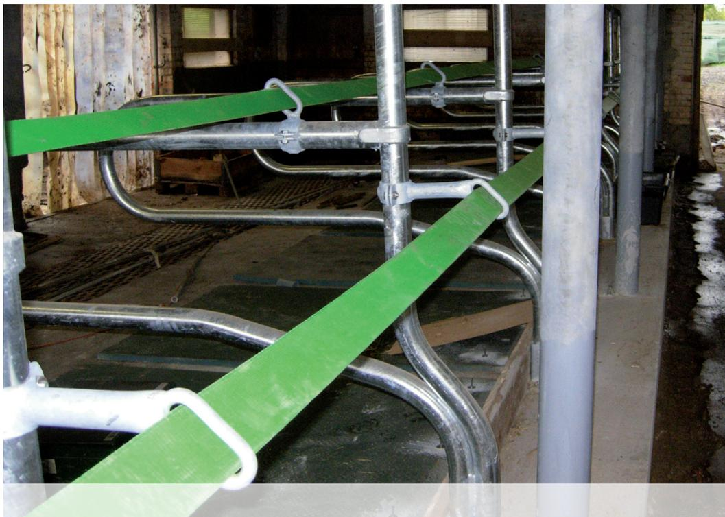
Der Libertybuegel bietet grösster Kuhkomfort. Der optimale Buegel für Milchvieh. Für Hoch- und Tiefboxen einsetzbar. Befestigung der Libertybuegel mit 4 Bolzenankerschrauben auf Boden und seitlich an Bugbalken. Zur Stabilisation wird ein 1 1/2" Rohr auf die Liegeboxen montiert. Die frontseitige Begrenzung erfolgt mit einem 75 mm Nackengurt.
