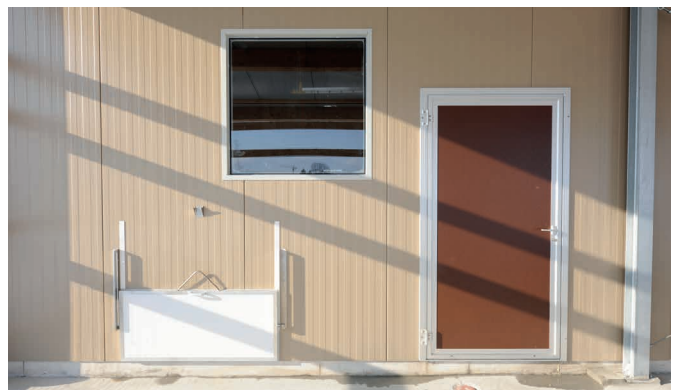
Türen, Fenster und Auslaufschieber
