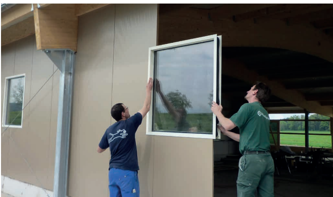
Wand- und Fenstermontage
