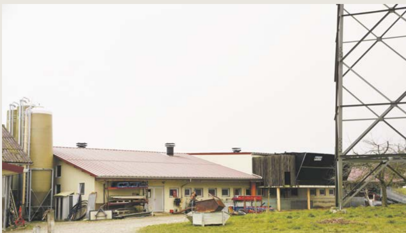
QM-Schweinemaststall mit 500 Plätzen und dreistufigem Bio-Luftwäscher (rechts).
